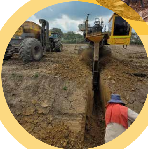
Instalación de drenajes entubados haciendas El Pindo y La Milagrosa
