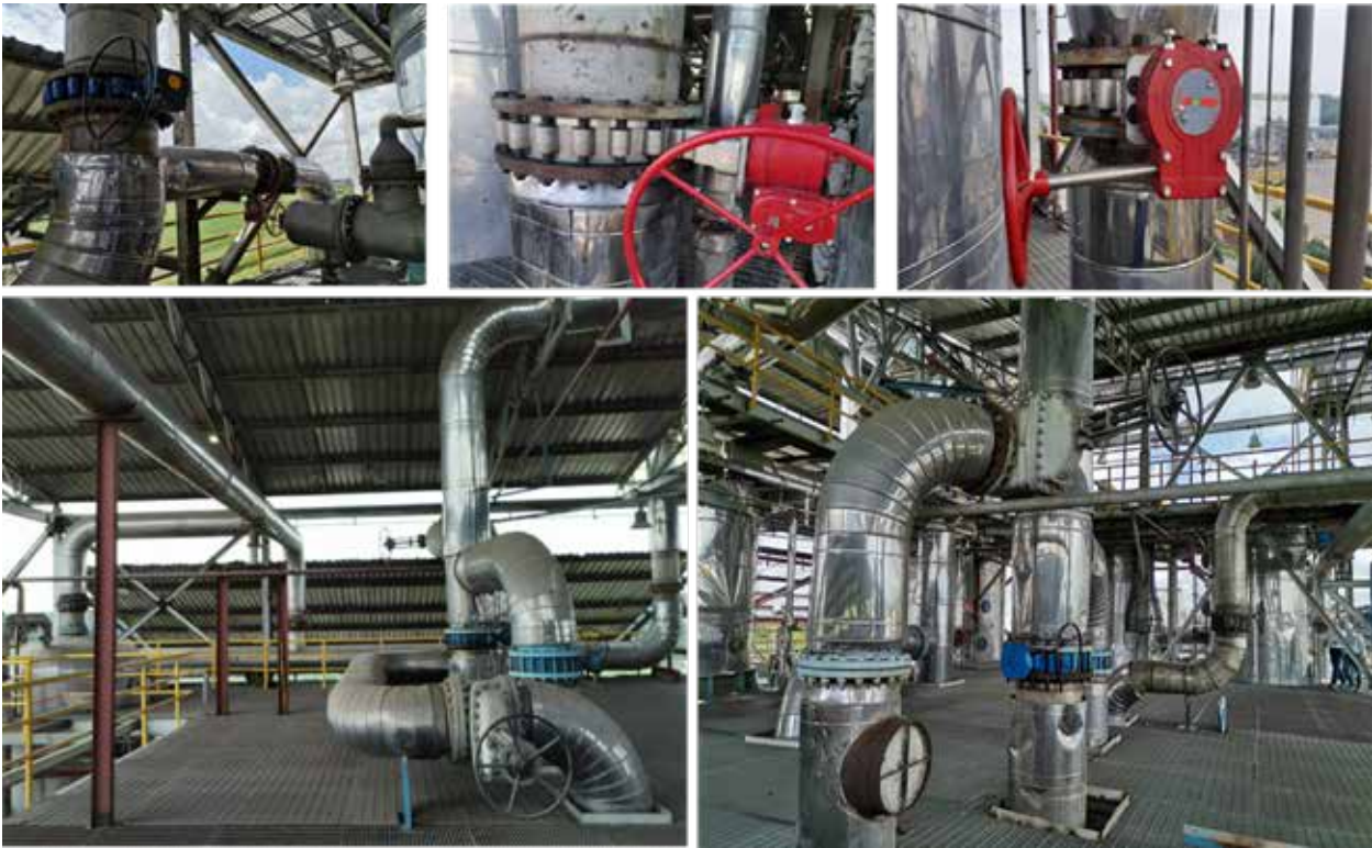
Instalación de conjunto de válvulas para aprovechamiento de vapores de vinaza
